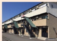
新設した外国人専用の寮（外観）
